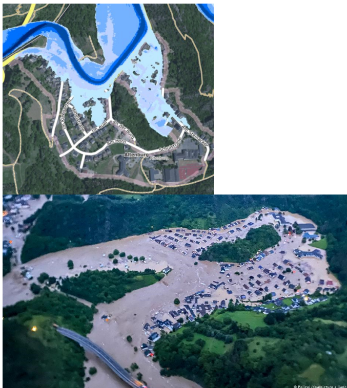
Abbildung 3 Vergleich der Hochwassergefahrenkarte von Altenburg (Ortsteil von Altenahr) für ein sehr seltenes Ereignis ( HQ_{\text{extrem}} ) 11 und der erfolgten Überflutung in 2021 (Blick nach Osten) 12 .
