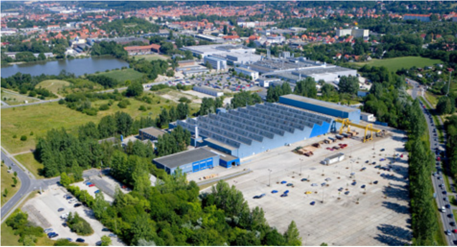
Blick auf den Investitionsstandort – das Werksgelände der VEM motors GmbH in Wernigerode, Sachsen-Anhalt
