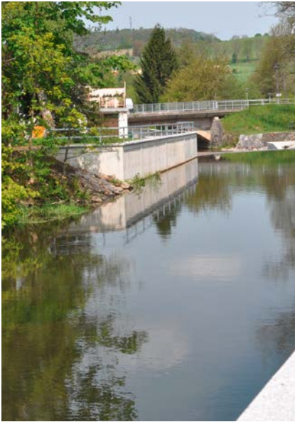
Ein neues Wehr mit Fischaufstiegsanlage
